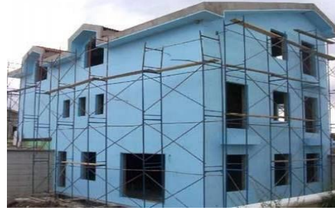
Şekil 175: Yalıtım malzemesi uygulaması
